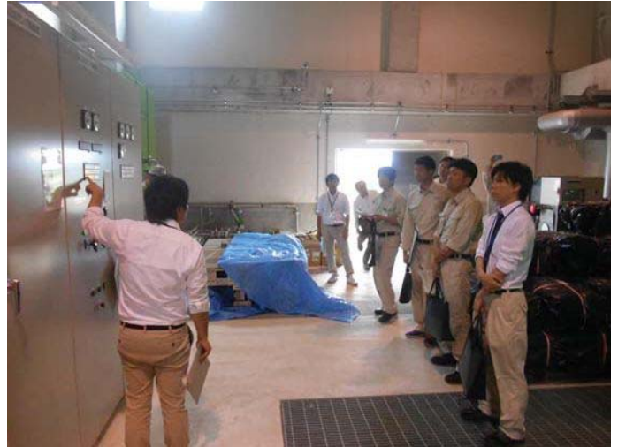
合同操作訓練（瓜生野川排水機場）
