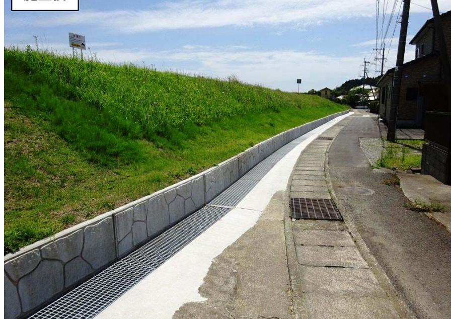
堤防の裏法尻部(宅地側)に排水ドレーンを設置。
