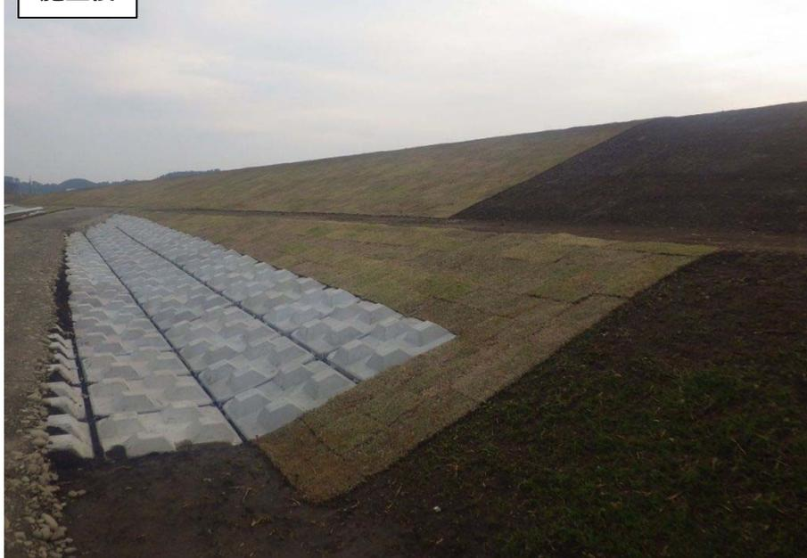
堤防の裏法尻部(宅地側)をブロックにて補強。
