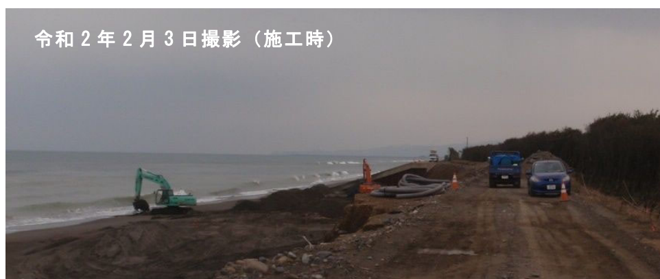
実施箇所状況
