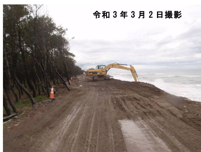
実施箇所状況
