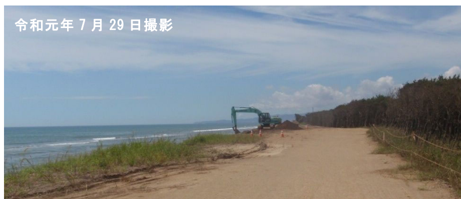
実施箇所状況
