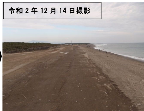
実施箇所状況
