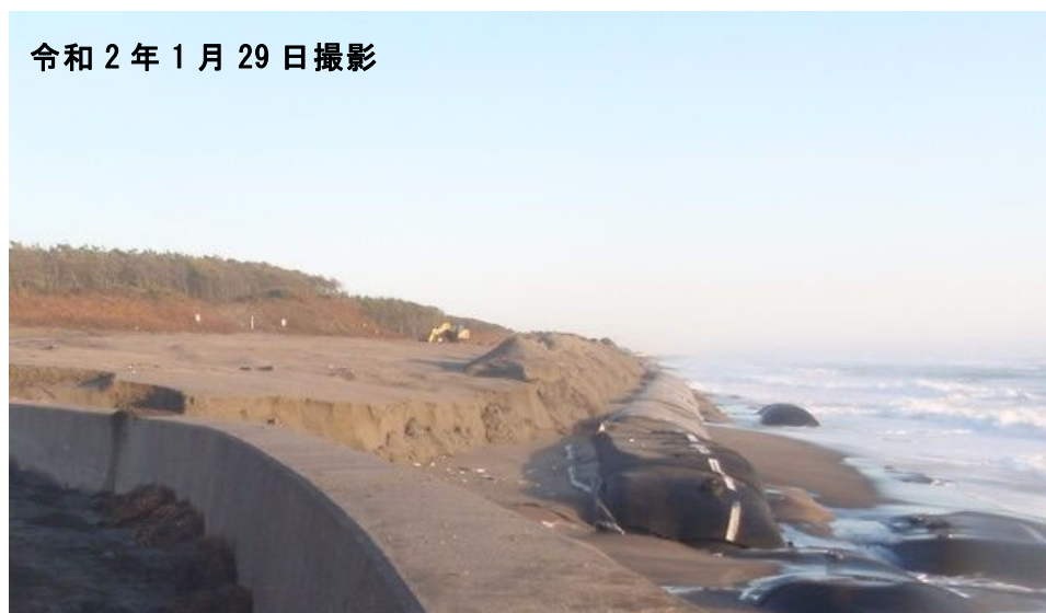
実施箇所状況
