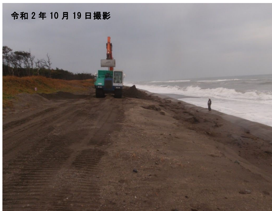
実施箇所状況
