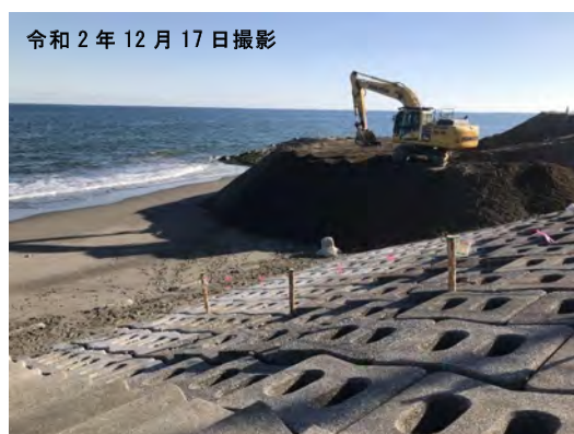
実施箇所状況
