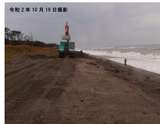
実施箇所状況
