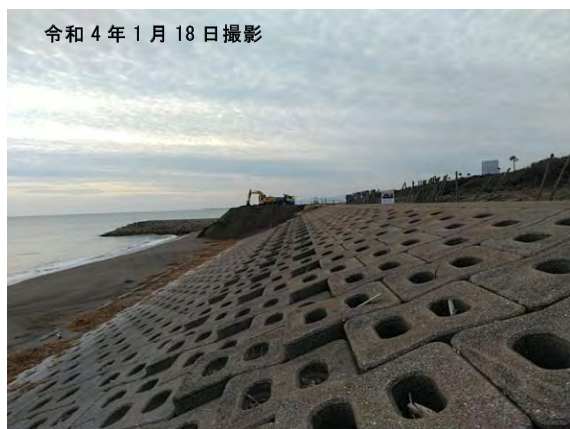
実施箇所状況
