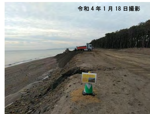
実施箇所状況
