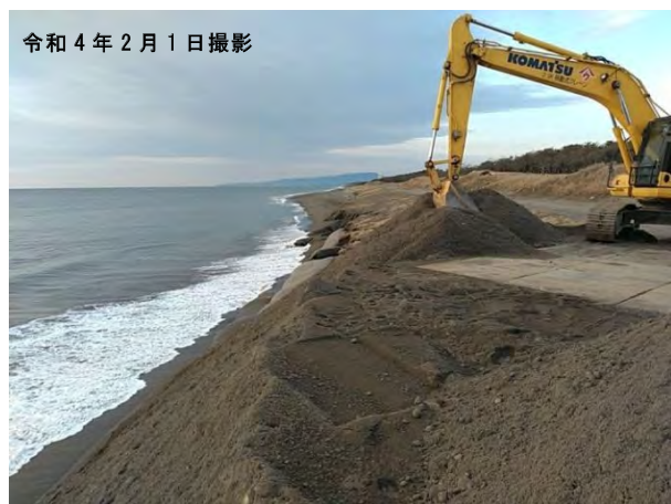
実施箇所状況
