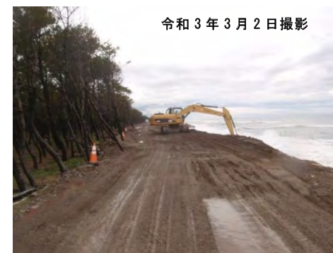
実施箇所状況
