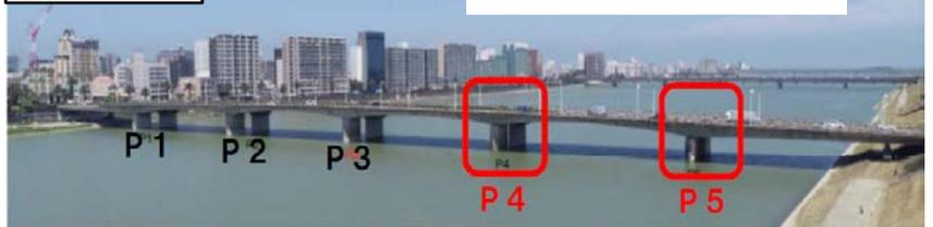
＜主な対策工：橋脚の鋼板巻き立て工＋落橋防止装置取り付け工＞
