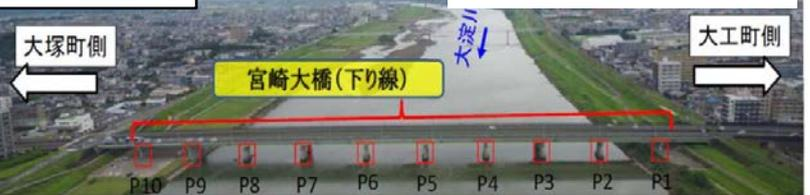
＜主な対策工：橋脚のポリマーセメントモルタル巻き立て工＞
