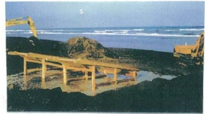
すなわち 砂抄工法による試験施工 我が国初の杉の間伐材を活用した 人工砂嘴形成による砂浜復元 宮田海江【宮崎新聞】
