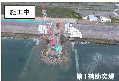
**まいせつごがん 埋設護岸** ③浜崖顶部高の低下を防ぐ 全国初のサンドパック工法を採用
