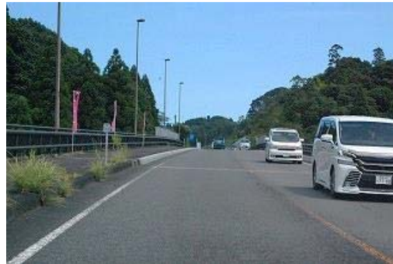
国道220号ルートの様子
