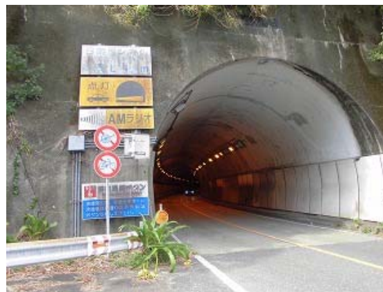
軽車両通行禁止の「日南隧道」
