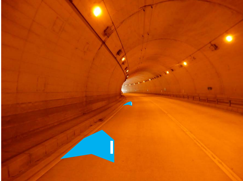
宮浦トンネル
