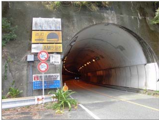
トンネルの状況
