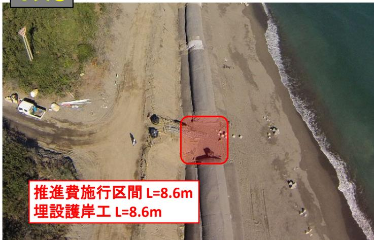
埋設護岸の整備状況写真(サンドパック充填後)
