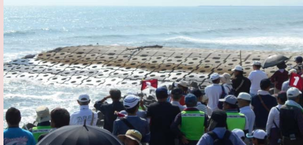
突堤での説明の様子
