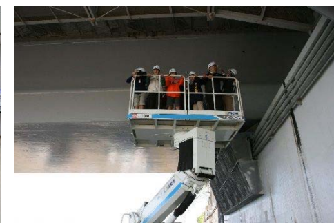
【リフト車での打音点検体験】
