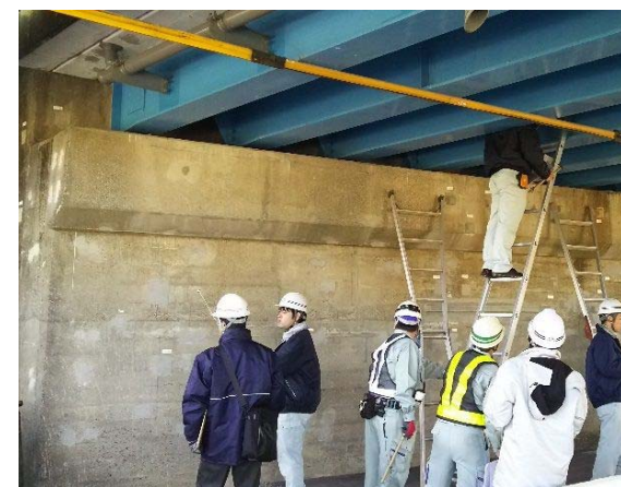
▲橋梁点検状況
