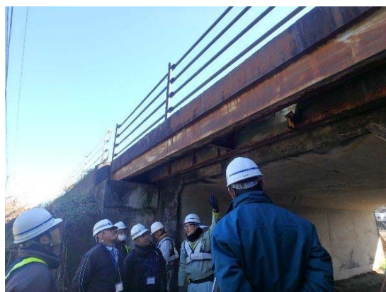
▲1月25日(木) 都城地区 国道10号溝橋 1市 4名
