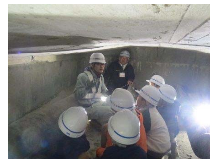
【箱桁の中での打音点検体験】
