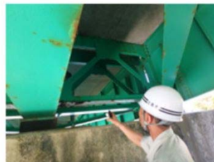
▲▼ 近接目視点検(橋脚付近)
