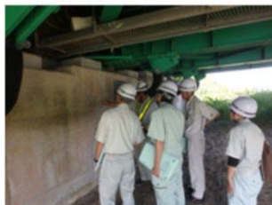
▲ コンクリート部材の損傷を確認(起点側 A1橋台)
