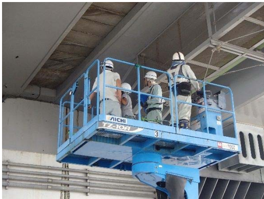
②高所作業車に乗り、橋桁に近づきました
