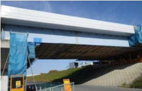
橋梁点検と補修工事で足場を共有
