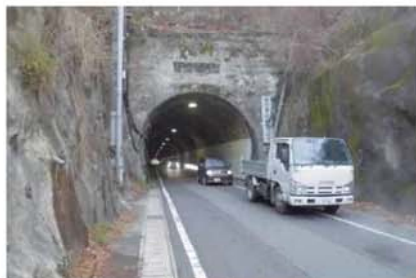
＜仁方隧道の状況＞
