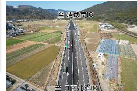
日南北郷IC付近の施工状況 (R4.12時点) 日南北郷IC側から清武南IC方面を望む
