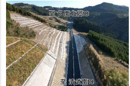
鏡洲地区の施工状況 (R4.12時点) 清武南IC側から日南北郷IC方面を望む
