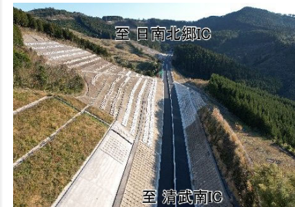
鏡洲地区の施工状況 (R4.12時点) 清武南IC側から日南北郷IC方面を望む
