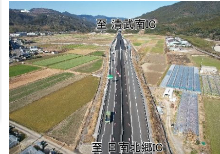
日南北郷IC付近の施工状況 (R4.12時点) 日南北郷IC側から清武南IC方面を望む
