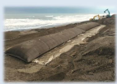
サンドバック再施工設置(R6年)
