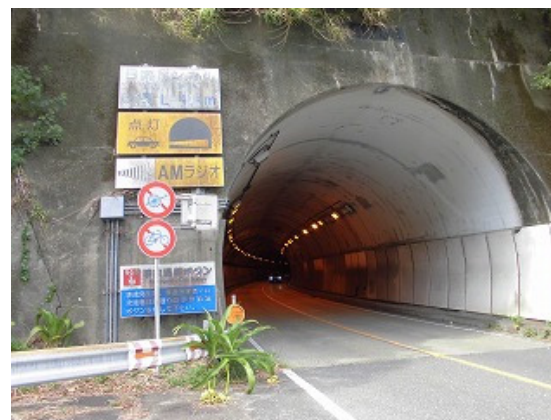
軽車両通行禁止の「日南隧道」
