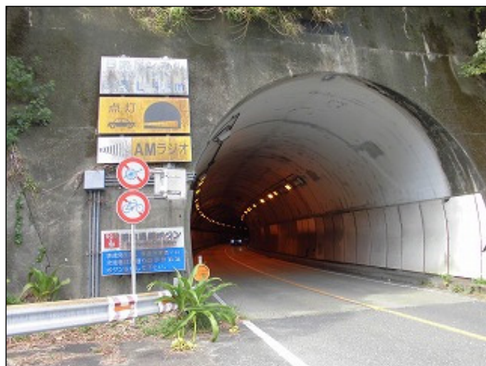
トンネルの状況
