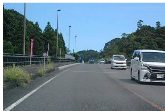
国道220号ルートの様子
