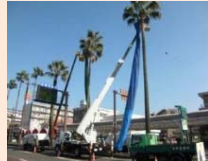
枯れ枝落下防止作業の状況 (1車線規制で32mまで)
