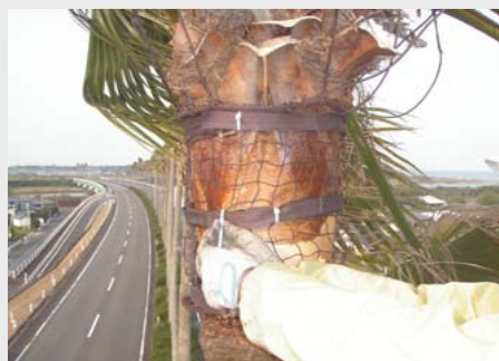
枯れ枝落下防止ベルトの設置
