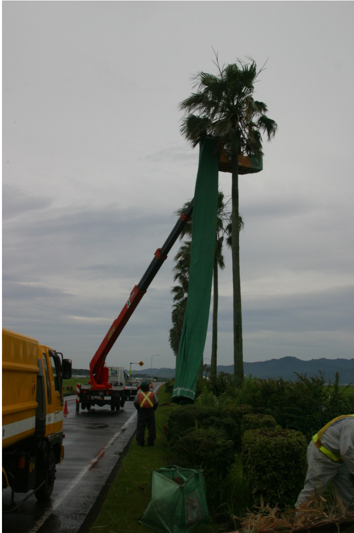
高所作業車による作業状況
