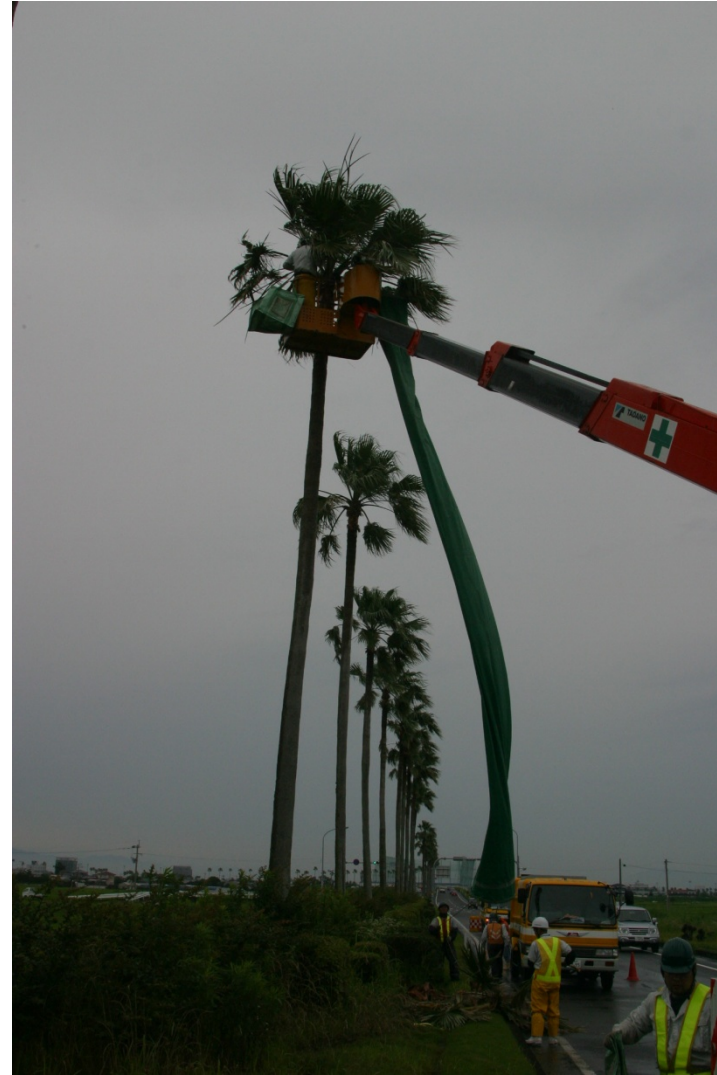
シューター 17 （枯枝が道路に飛ばないようにこの中を通して落とす）
