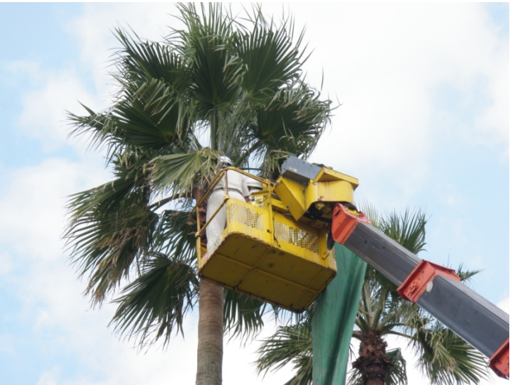
高所作業車 ボックス
