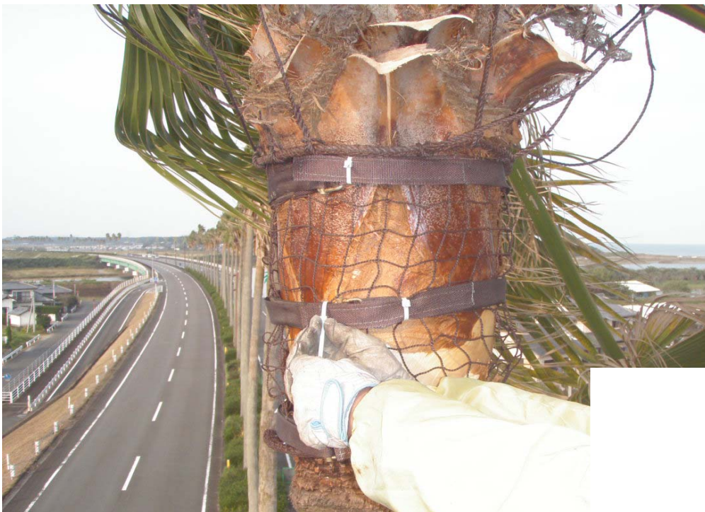
落下防止ベルト設置
