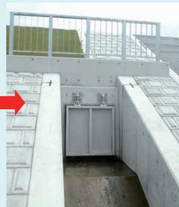
劣化したゲートの更新に伴い、ゲートの無動力化を行う。応急対策は、老朽化した既設構造物の改良を行い、構造物の信頼性向上及び長寿命化を図るものです。
