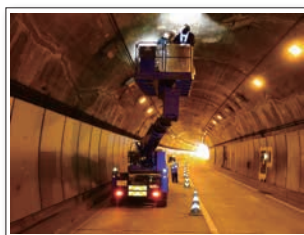
リフト車による点検
