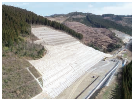
切土工事（R2.2末時点）
