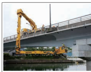
橋梁点検車による点検
