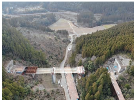
上部工架設工事（R2.2末時点）
