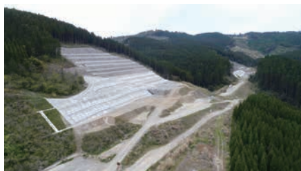
切土工事（H31.4末時点）
