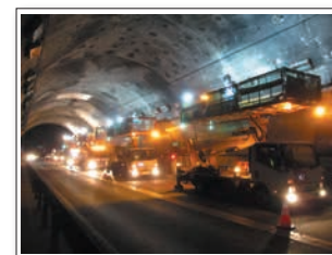
トンネル補修状況
