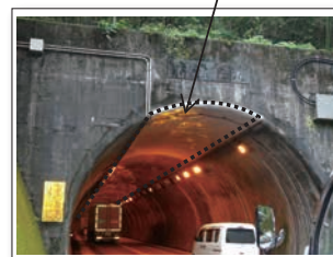
トンネル補修
