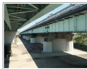
橋脚の耐震補強完了
