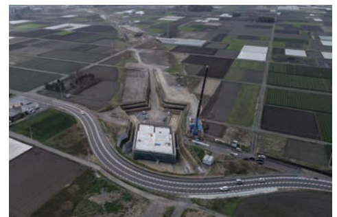
(乙房IC)付近の施工状況(R2.2未時点) 都城IC方面から横市IC方面を望む
