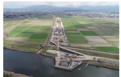
大淀川橋の施工状況(R2.2未時点) (乙房IC)方面から都城IC方面を望む
