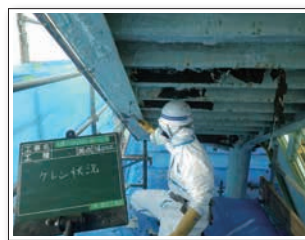
橋の補修状況（塗装作業）
