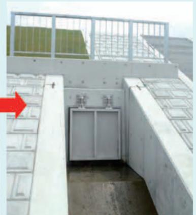
劣化したゲートの更新に伴い、ゲートの無動力化を行う。応急対策は、老朽化した既設構造物の改良を行い、構造物の信頼性向上及び長寿命化を図るものです。
