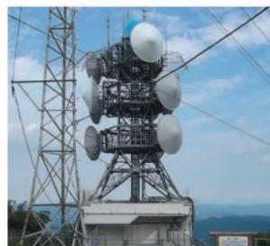
マイクロ回線を利用して、防災情報などの情報を中継します。
