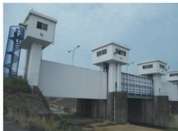
出水時には水門を閉じて、本川の水が支川へ流れ込むのを防ぎます。
