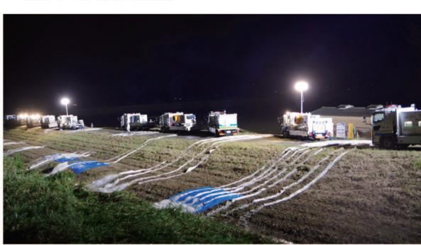
▲災害対策車(照明車・排水ポンプ車)による排水作業
