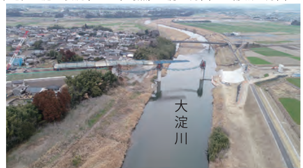
大淀川橋の施工状況（R4.2末時点） 大淀川上流から下流を望む
