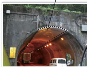
トンネル補修
