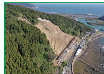
応急復旧後写真②
