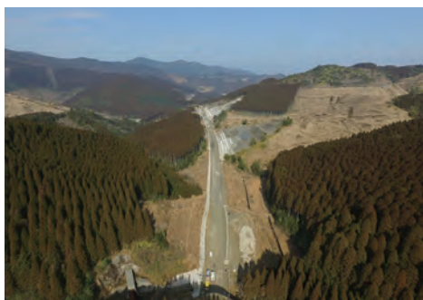
鏡洲地区の施工状況 (R4.1 末時点) 日南北郷 IC 側から清武南 IC 方面を望む
