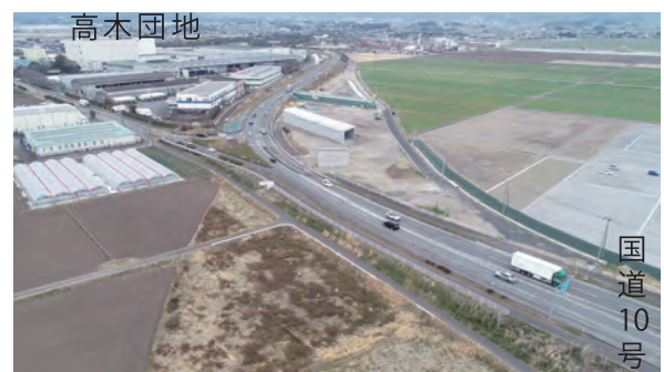
高木地区の施工状況（R4.2末時点） 乙房IC方面から都城IC方面を望む
