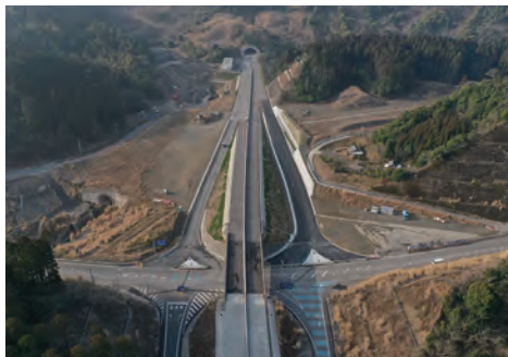
清武南 IC 付近の施工状況 (R4.2 末時点) 清武南 IC 側から日南北郷 IC 方面を望む
