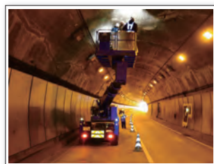
リフト車による点検
