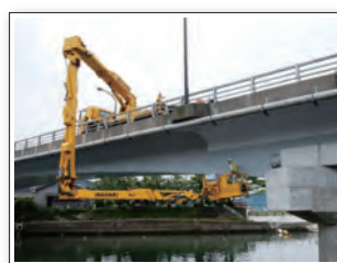
橋梁点検車による点検
