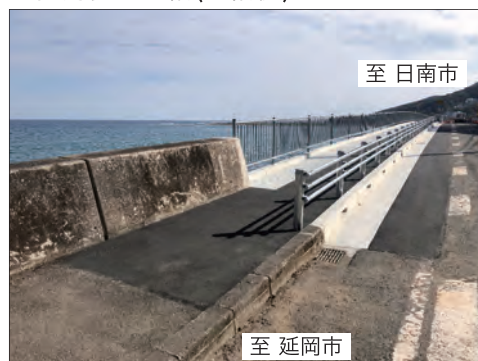
小内海歩道整備(整備後)
