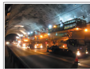
トンネル補修状況
