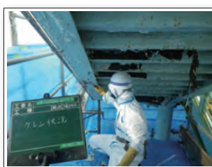
橋の補修状況（塗装作業）
