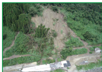
応急復旧前写真
