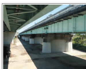
橋脚の耐震補強完了
