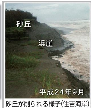
**砂丘の侵食を防ぐために浜崖の根元を保護する。**
