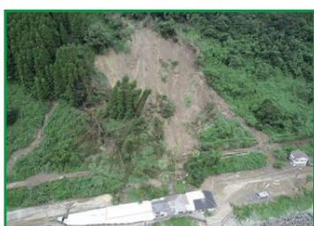
応急復旧前写真
