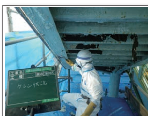
橋の補修状況（塗装作業）
