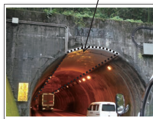
トンネル補修
