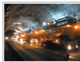
トンネル補修状況
