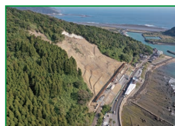
応急復旧後写真②
