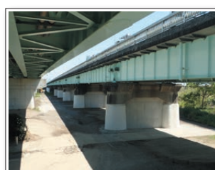
橋脚の耐震補強完了
