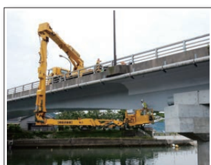
橋梁点検車による点検
