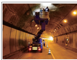
リフト車による点検
