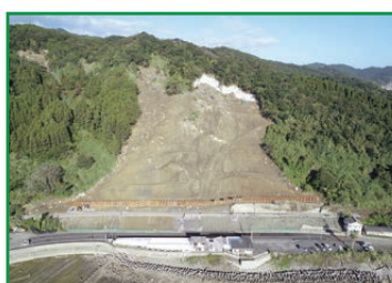
応急復旧後写真①
