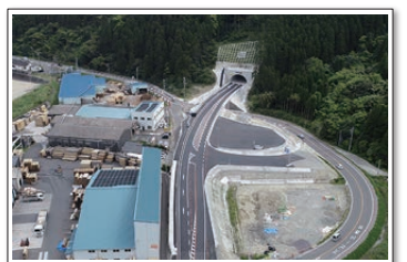
伊比井潮風トンネル 坑口付近全景 (宮崎市側)
