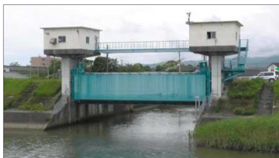
津波対応管理施設 (山内川水門)
