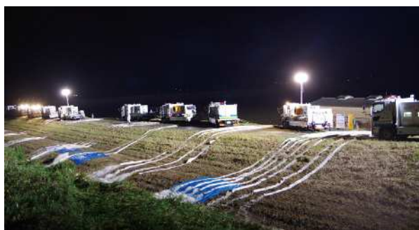
▲災害対策車（照明車・排水ポンプ車）による排水作業 （令和元年8月 佐賀県）
