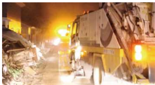
▲災害対策車（路面清掃車）による清掃作業 （令和2年7月 熊本県人吉市）
