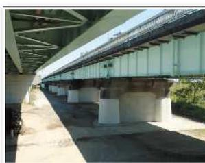
橋脚の耐震補強完了
