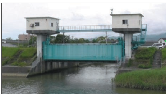
津波対応管理施設 (山内川水門)
