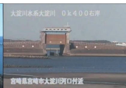
大淀川河口付近 (宮崎港水門)
