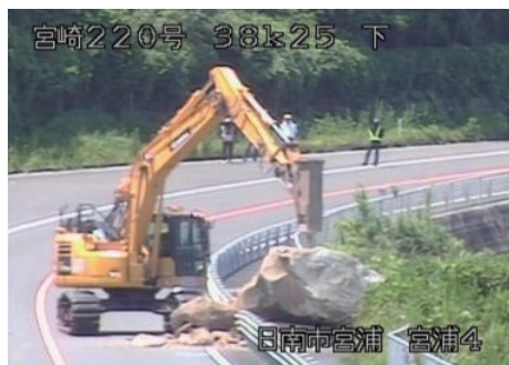
▲遠隔操縦操作（ロボ QS）を使用した落石撤去作業 (令和6年8月 日南市)
