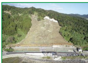
応急復旧後写真①
