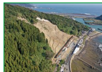
応急復旧後写真②
