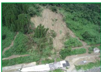
応急復旧前写真
