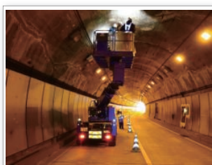
リフト車による点検
