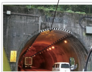
トンネル補修
