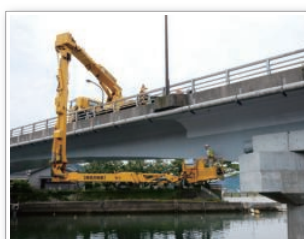
橋梁点検車による点検
