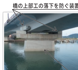
橋脚が壊れないように強くする
