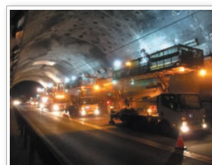
トンネル補修状況
