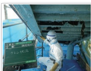
橋の補修状況（塗装作業）
