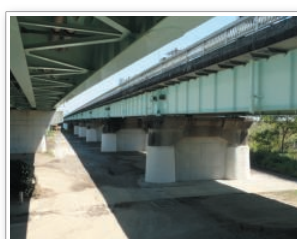
橋脚の耐震補強完了
