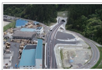
伊比井瀬風トンネル 坑口付近全景 (宮崎市側)
