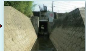
大淀川・小丸川の堤防、護岸などの点検と修繕、水門・樋門などの維持管理、堤防・高水敷の除草などを実施し、施設の保全、災害防止に努めます。
