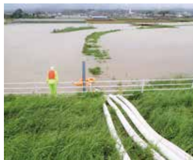
▲排水ポンプ車による排水作業 (令和6年8月 西都市)
