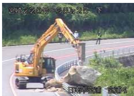
▲遠隔操縦操作(ロボQS)を使用した落石撤去作業 (令和6年8月 日南市)
