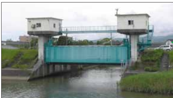
津波対応管理施設 (山内川水門)
