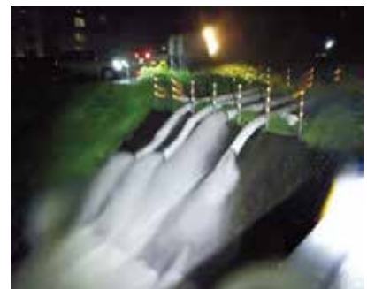
▲排水ポンプ車による排水作業 (令和6年8月 都城市)
