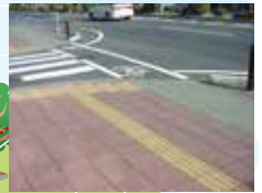
歩行空間を確保し点字ブロックを設置。
