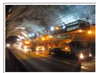
トンネル補修状況
