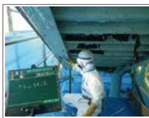
橋の補修状況（塗装作業）
