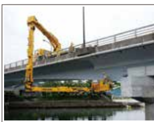
橋梁点検車による点検
