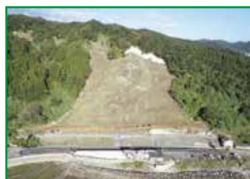
応急復旧後写真①
