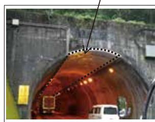
トンネル補修
