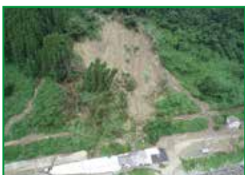
応急復旧前写真
