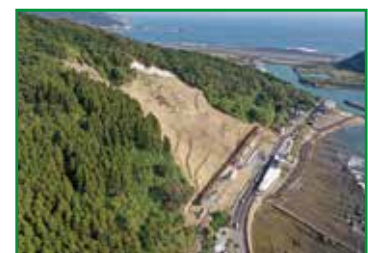
応急復旧後写真②
