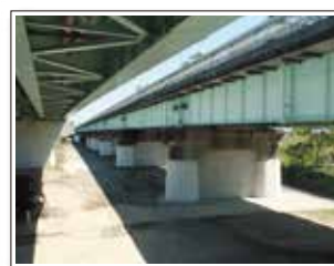
橋脚の耐震補強完了
