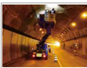
リフト車による点検
