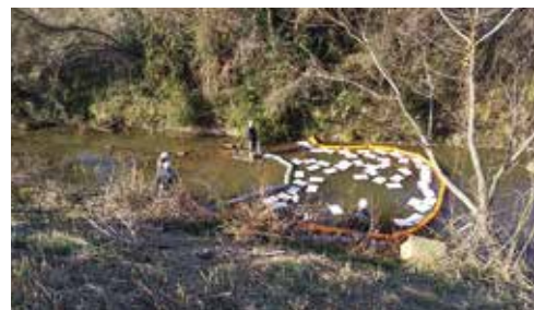
油流出事故が起こった場合は、オイルフェンスを設置して、油を回収します。
