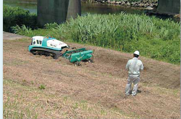
機械を使用した除草工事
