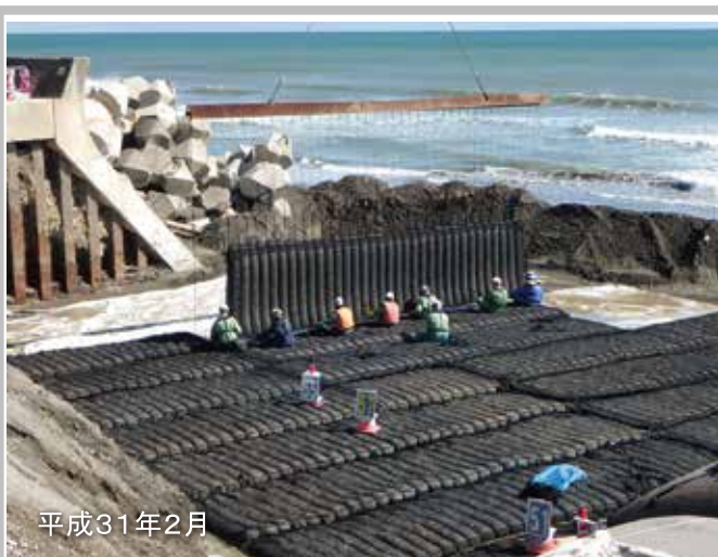
洗掘対策の施工(住吉海岸)
