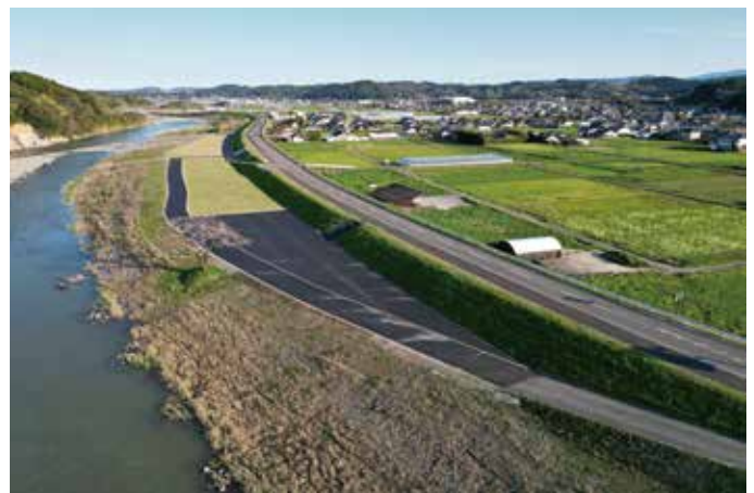
本庄川かわまちづくり(綾町) (完成写真)
