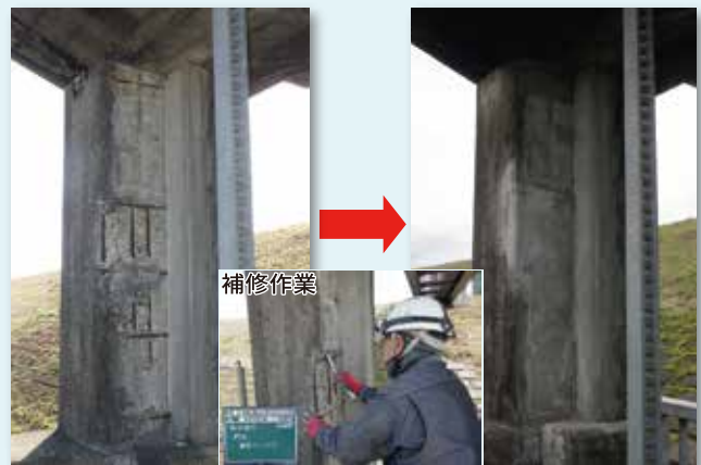
樋管補修の実施事例
