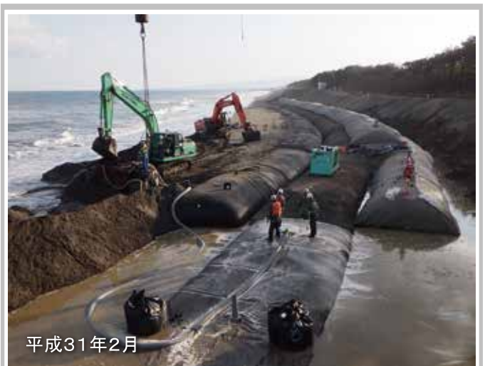
サンドパックの充填作業(住吉海岸)
