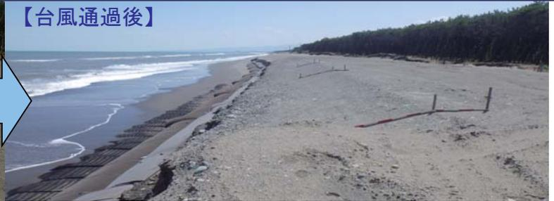
昨年度埋設護岸サンドパックの施工が完了しました。台風通過の際、高波浪により砂浜は侵食されますが、埋設護岸サンドパックが浜崖の後退を防いでいます。
