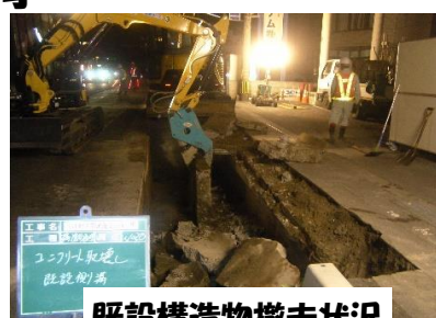
既設構造物撤去状況
