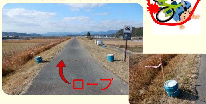
■十日町樋管上流堤防天端
