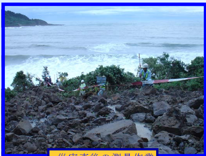
災害直後の測量作業
