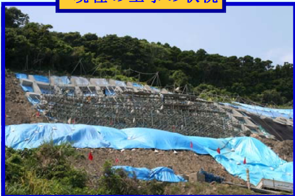
現在の工事の状況
