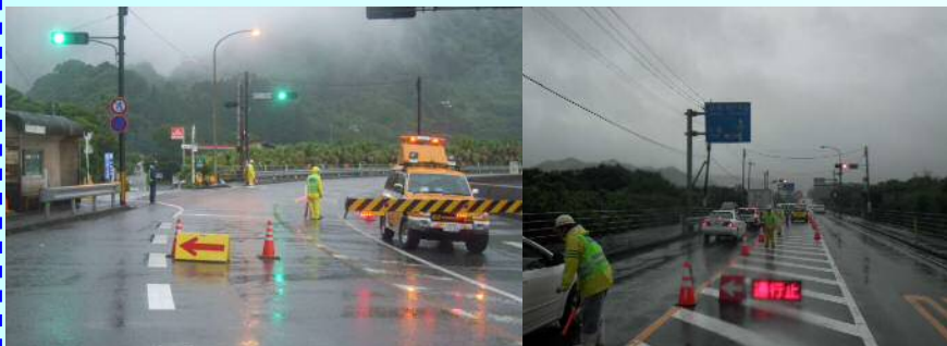
通行規制区間の様子
