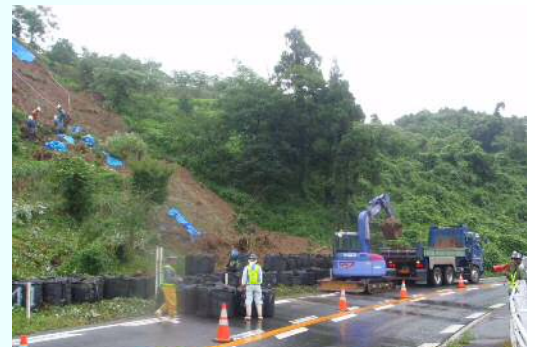
榎原法面の復旧作業中の様子
