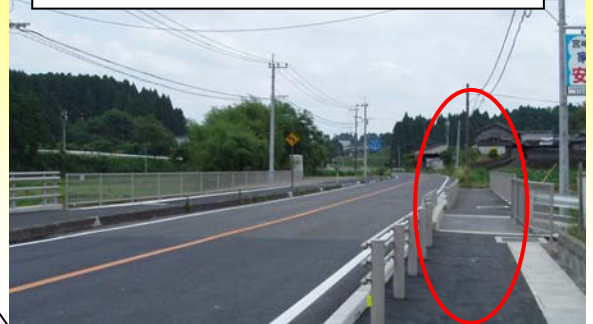
道路の両側に歩道を設置しました。
