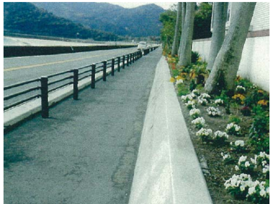
国道220号 宮浦海岸前
