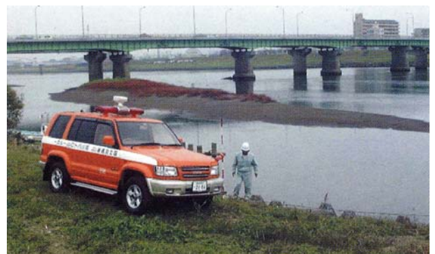
写真 4.3.2 河川巡視状況
