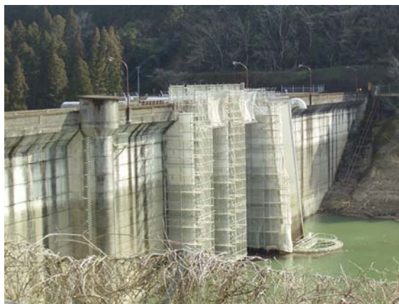
写真 4.3.1 ダムの補修点検
