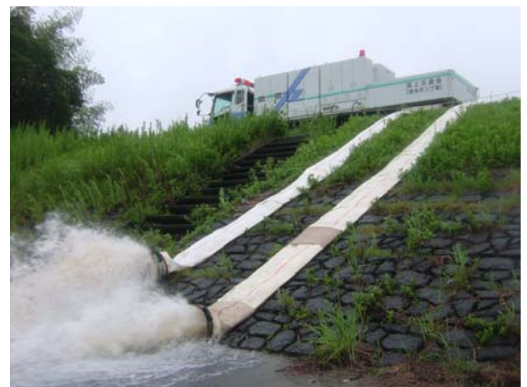
写真 4.3.5 排水ポンプ車の稼動状況 (平成 17 年 台風 14 号出水時)
