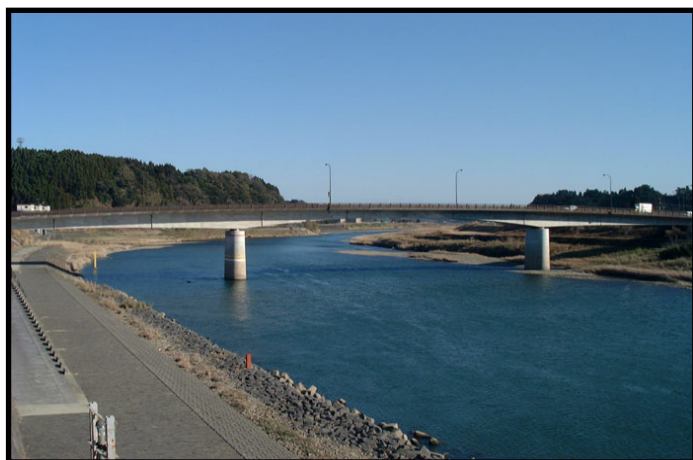
五町堤防より大の丸橋を望む （平常時）
