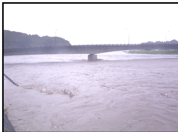
五町堤防より大の丸橋を望む （平成16年8月 台風16号出水時）
