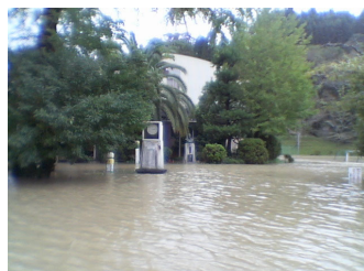
穆佐小学校 平成16年8月 台風16号 出水時
