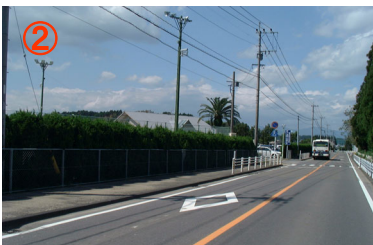
県道 日南・高岡線 サン・スポーツランド付近 平成16年9月 平常時
