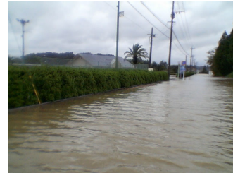
県道 日南・高岡線 サン・スポーツランド付近 平成16年8月 台風16号 出水時
