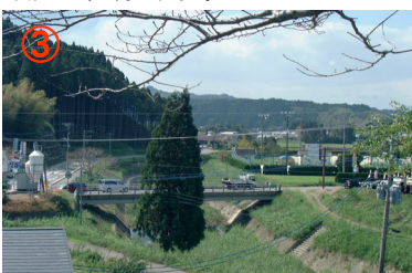
県道 日南・高岡線 番所橋付近 平成16年9月 平常時
