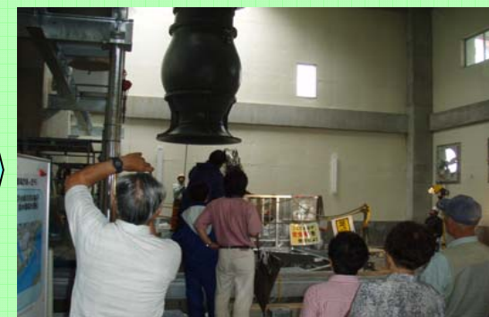
ポンプ据付の様子（内部）
