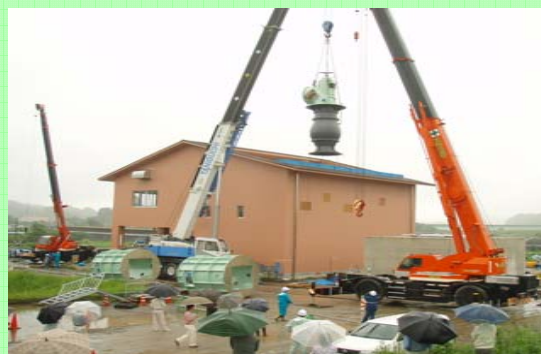
ポンプ据付の様子（外観）
