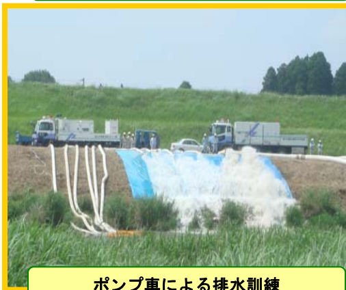
ポンプ車による排水訓練
