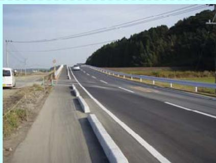
吉野地区築堤工事では、工事に伴い7月より行っていた県道の迂回について、11月4日に本復旧が完了しました。
