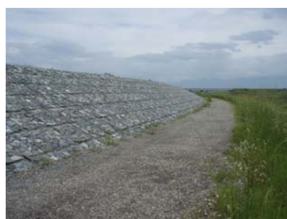
金崎堤防漏水対策
